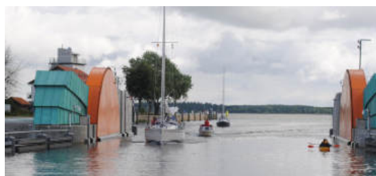
Inlopp Greifswald. Luckor som skyddar mot högsvatten.
