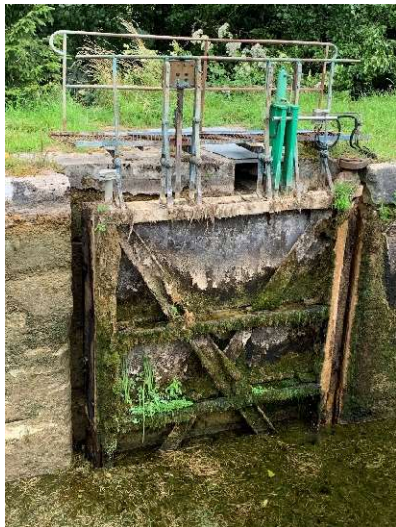
Eftersatt underhåll i slussarna
